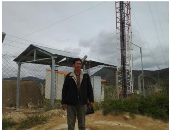
Antena de telecomunicaciones y Tanque de agua Uriondo
