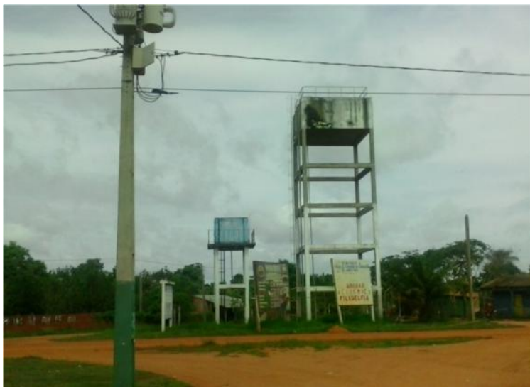
Sistema de agua y energía eléctrica en municipio de Filadelfia
