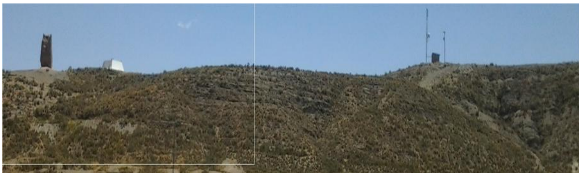
Tanque y antenas de telecomunicación en Soracachi
