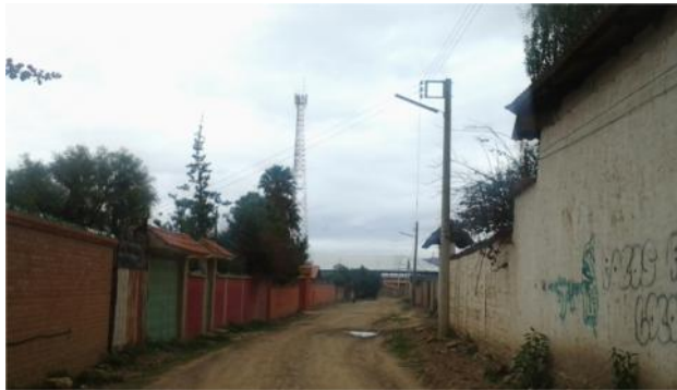
Instalación de gas, tanque de agua y antenas de telecomunicación municipio Santivañez
